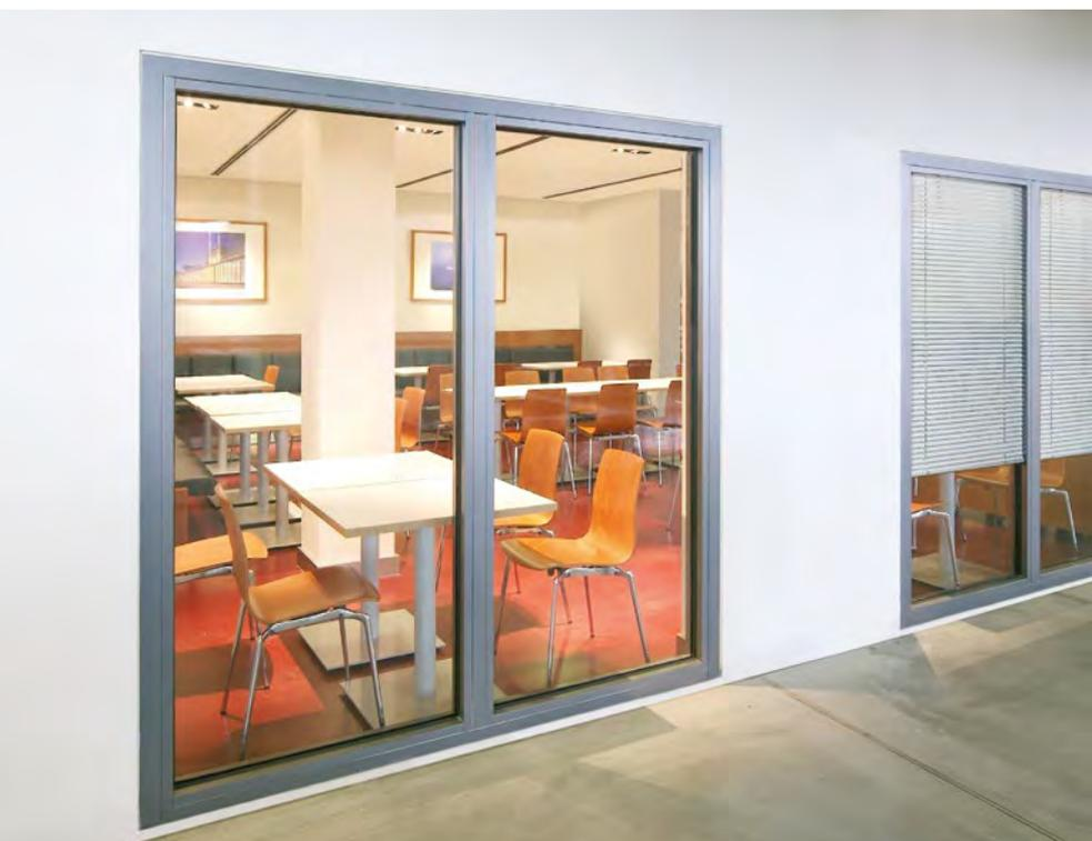
LINKS. Schallschutzverglasung HW-D-SD mit Sichtschutz im Fensterzwischenraum
