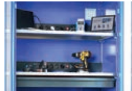
Zentrale Versorgung von Akkus und E-Geräten
